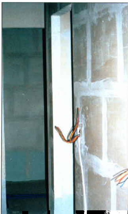
Georges De Vlioger: "Quand on a achevé une cloison en blocs de plâtre, on n'en est fier car elle fait solide et massive." (Photo: Cloison en blocs de plâtre en première phase)
