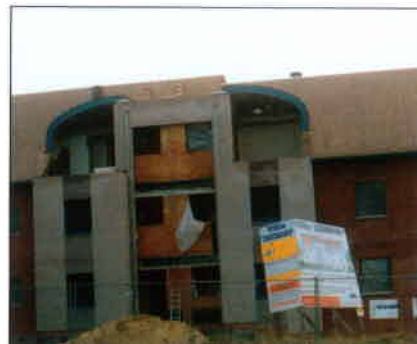
Gipsconstruct pose 65% de ses blocs de plâtre dans des appartements. Projet: Appartements de luxe 'De Zeebries' (Koksijde). Maître-d'œuvre: Eurobel Invest (Koksijde). Architecte: Guido Vanhoutte (Veurne).
