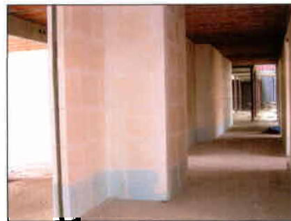
Cloisons acoustiques en blocs de plâtre d'une hauteur de 3m50: 2 rangées de blocs et une rangée de laine acoustique Isofoam entre les deux.
