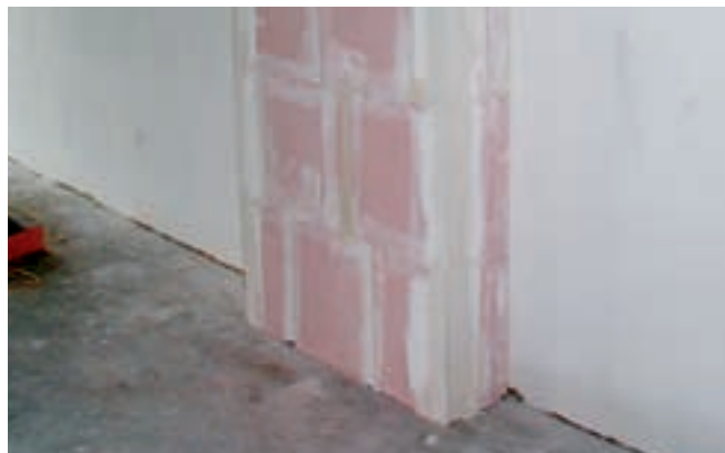
Le passage de conduites représente généralement un point faible lors du cloisonnement de locaux. Les blocs de plâtre se prêtent parfaitement à la construction de cloisons de gaines techniques.
