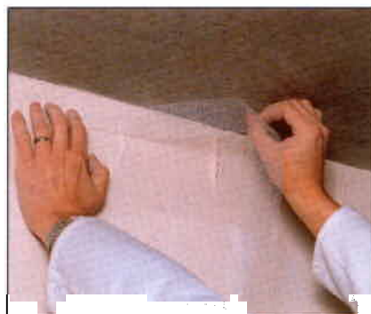
la pose de la bande à joints
